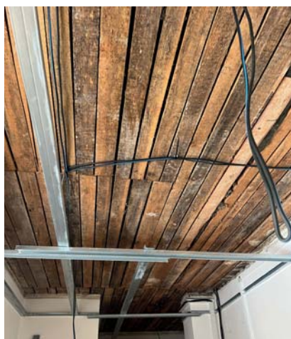
Strop na „Blažkovci“ při rekonstrukci.
