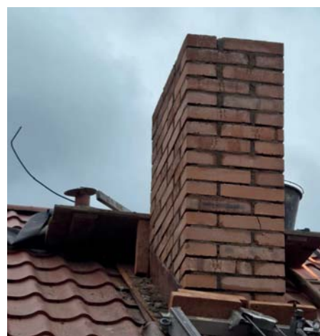
Opravený komín na prodejně.
