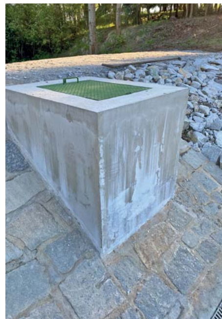
Opravený požerák (výpustní objekt).
