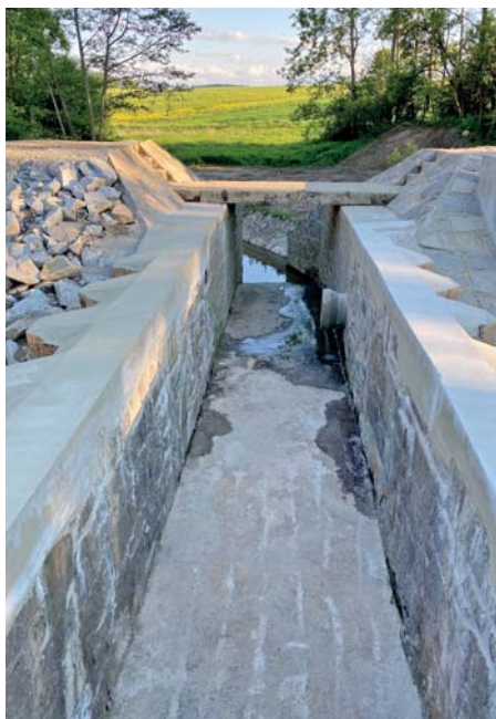
Rekonstruovaný bezpečnostní přeliv.
