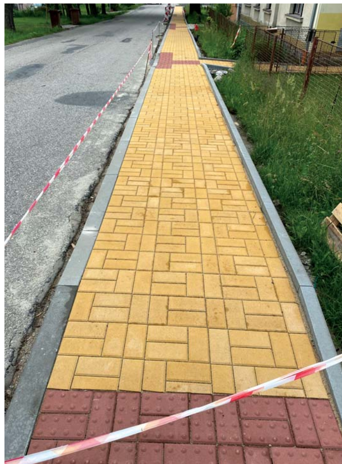
Rekonstruovaný chodník. Barvu dlažby navrhlo zastupitelstvo.
