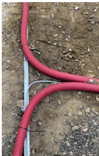
Při opravě byl instalován nový rozvod el. připojení.
